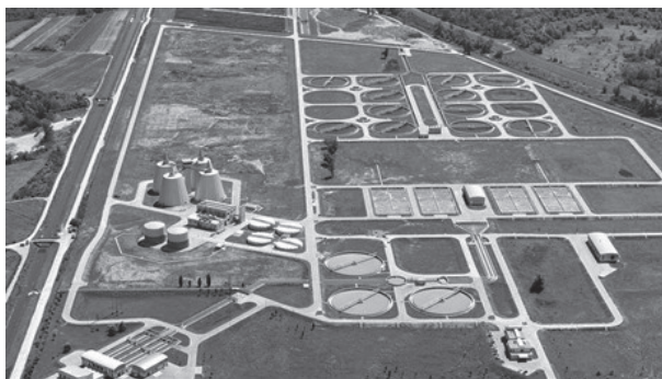
Zagrebački pročistač voda (2. prosinca 2011.)
