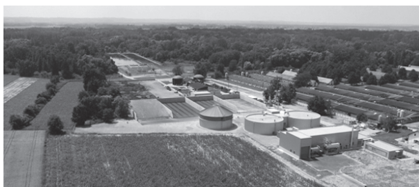
Bioplinsko postrojenje Nemščak, Murska Sobota (27. i 28. X. 2011.)
