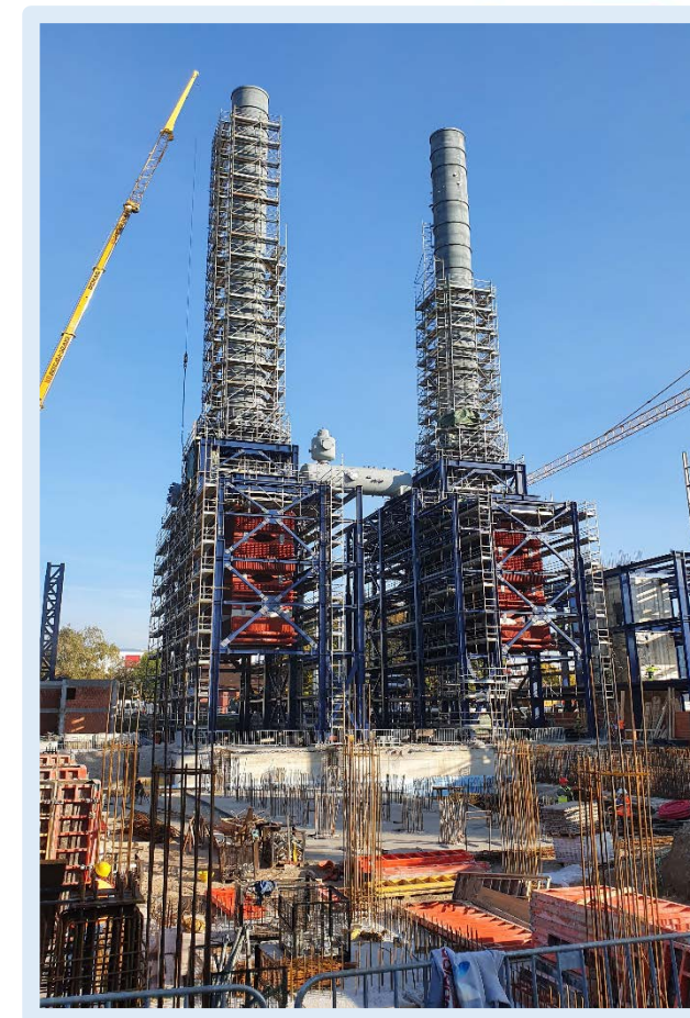
Postrojenje u fazi izgradnje – čelična konstrukcija s kotlova na ispušne plinove, u sredini napojni spremnik s otplinjačem
