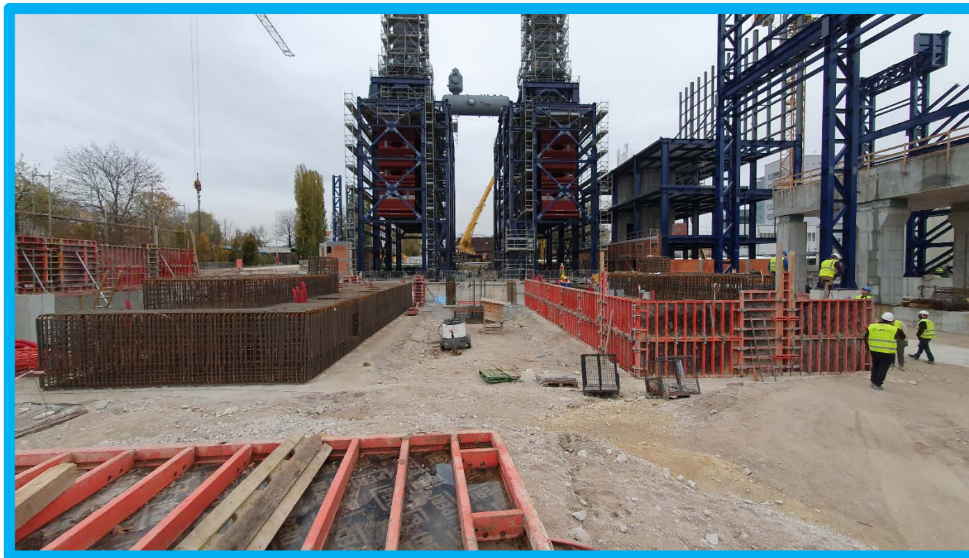
Postrojenje u fazi izgradnje – čelična konstrukcija s kotlova na ispušne plinove, naprijed se vide temelji za plinske turbine a desno temelj za parnu turbinu
