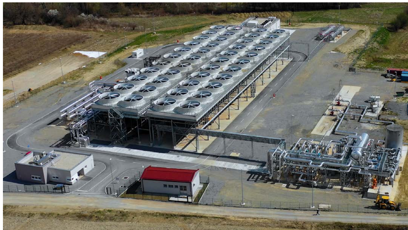
Fotografija 1. Geotermalna elektrana Velika 1, lokacija: Ciglena, Hrvatska
